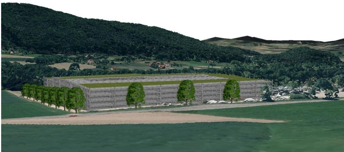
Abb.7: Vorschlag eines Parkdecks mit Außen- und Dachbegrünung (DGM1, DOP20, BIM, DOM40)
